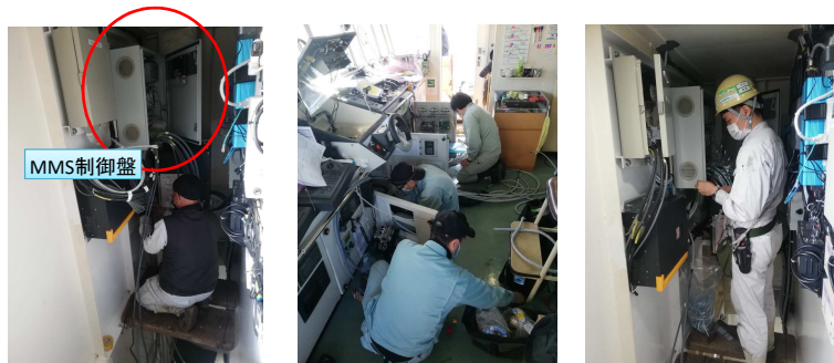
749GT内航コンテナ船「みかげ」MMS搭載工事の状況
