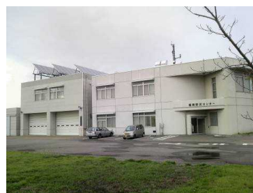
防災センター概観
