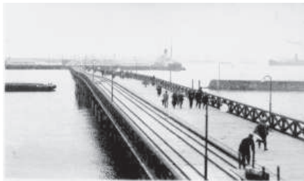
木造栈橋完成 (函館)
