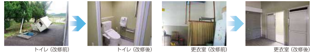
トイレ (改修前)
