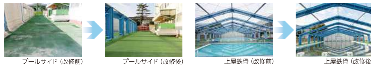
プールサイド (改修前)
