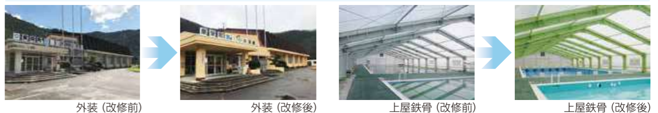
外装(改修前) 外装(改修後) 上屋鉄骨(改修前) 上屋鉄骨(改修後)
