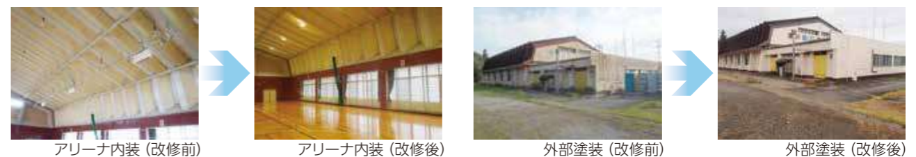
アリーナ内装 (改修前)
