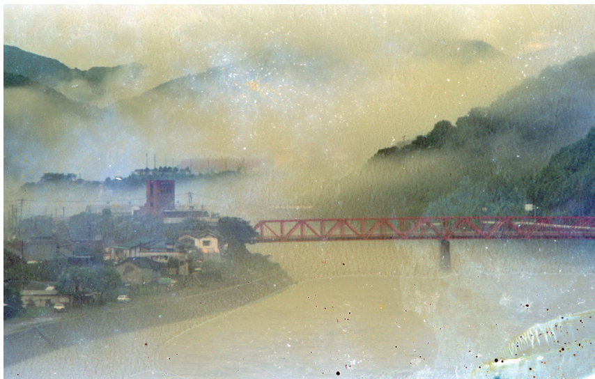
撮影年月日不明 219号線から坂本町の中心部へと続く坂本橋。令和2年7月豪雨にて流失。 水損の激しかった35mmカラーフィルムのデジタルデータ 撮影：東儀一郎氏
