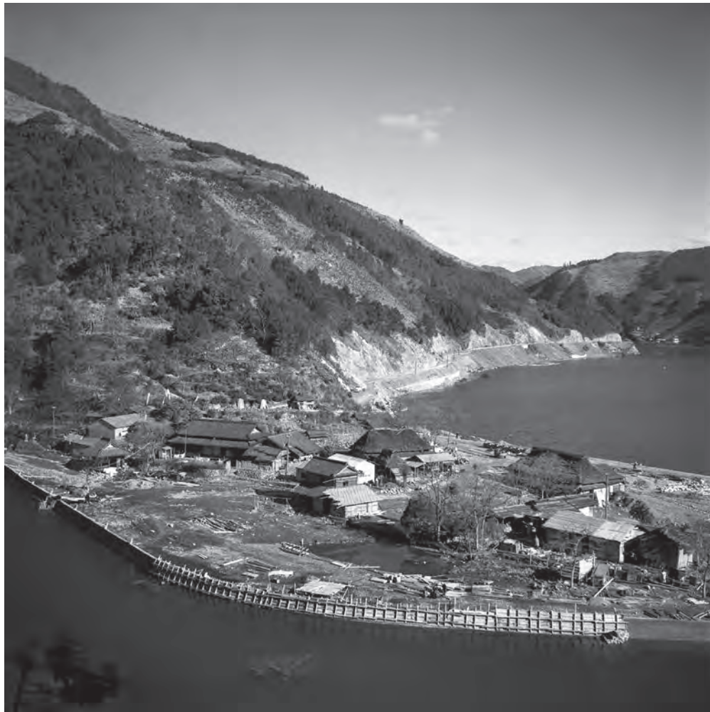
水没する破木集落 嵩上げ工事のための解体中の定点写真 昭和30年1月、破木 撮影：本村孝夫氏 Sinking Hagi village. A series of a dismantling village to raise the riverbank. Hagi, January 1955 Photo : Takao Motomura
