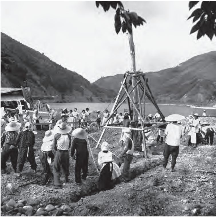
嵩上げ工事の固め作業 昭和30年9月5日・8日、破木 撮影：本村孝夫氏 Stabilization to raise the riverbank. Hagi, September 5 and 8, 1955 Photo: Takao Motomura
