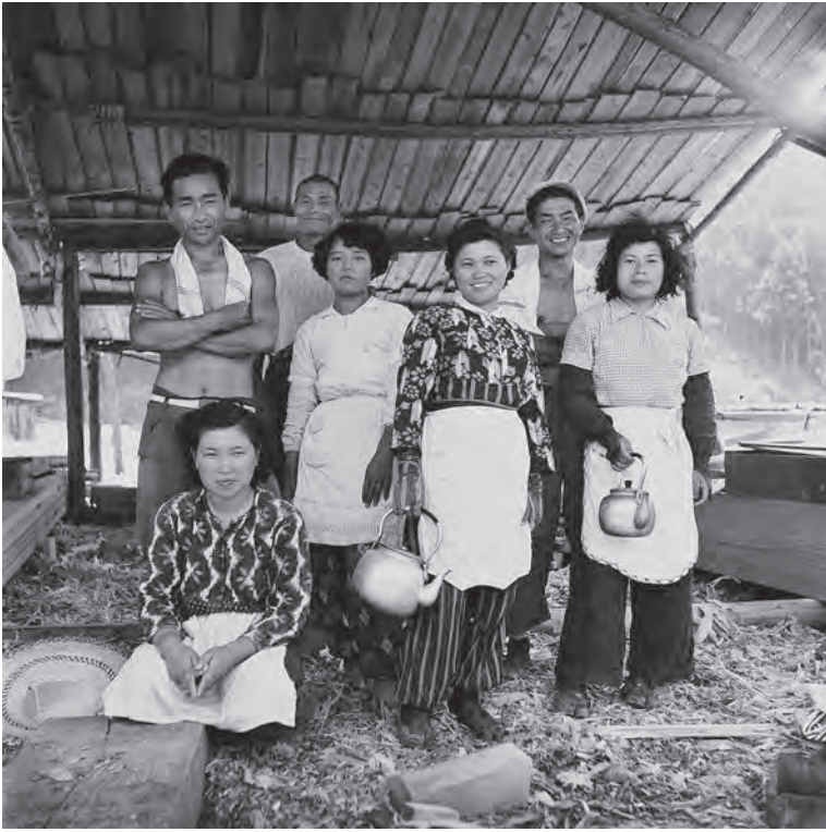
嵩上げ工事の現場にて 昭和 30 年 9 月 5 日、破木 撮影：本村孝夫氏 At a construction site to raise the riverbank. Hagi, September 5, 1955 Photo : Takao Motomura
