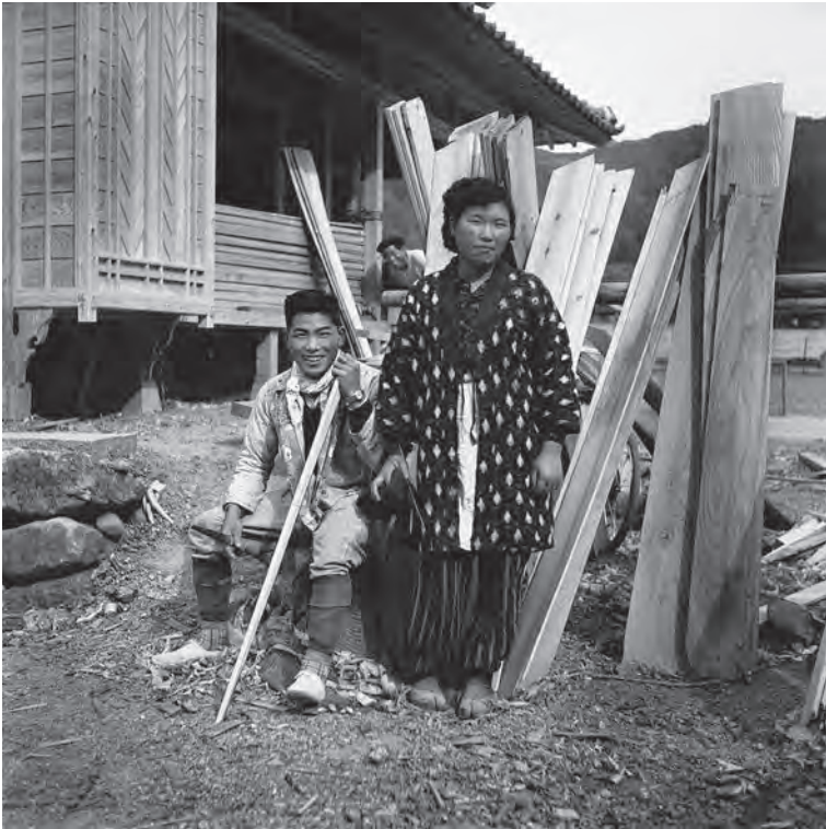
基礎打ちの現場にて
