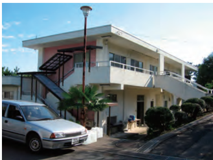
実習施設実習・研究棟
