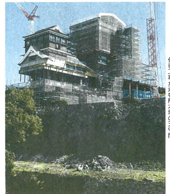
修復工事が進む熊本城の天守閣
