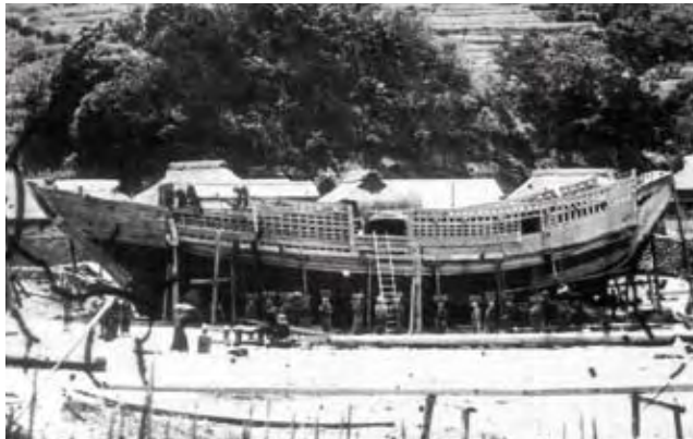
明治20年(1887)頃、南伊豆で建造中の弁才船の様子(個人蔵)
