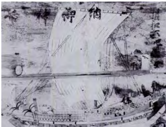
明和6年(1769)に和歌山の比井若一王子神社に奉納された船絵馬 この時代は樽廻船の多くを紀州廻船が占めていました。本図も伝馬船 でんまふね の位置 ちゐ や五尺 ごせき が取り付け られているところを見ると満載状態ですが、艙 ぐら の間に搭載物が見えないので、樽廻船を描いた 可能性が高いと思われます。
