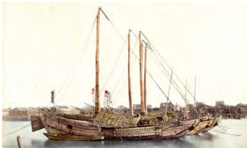
大阪で撮影された停泊中の弁才船の写真。表垣立は上筋が通常より1本少なく高さが低く抑えられていること、満載状態にもかかわらず蛇腹垣がなく常苦が低いことなどから、樽廻船ではないかと言われています。(松木哲氏蔵)
