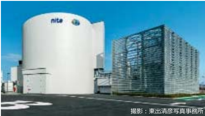
多目的大型実験棟・排煙処理設備の外観
