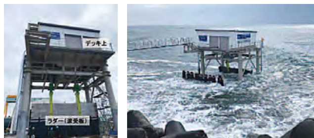
左：出荷直前の波力発電装置。右：設置後の平塚波力発電所（アルミ板とゴム板を組み合わせたゴムラダーを開発）
