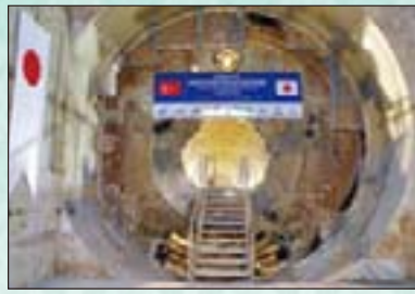
アジア側のシールドマシン(TBM)と沈埋面の接合 2010年4月 提供:大成建設株式会社 国際支店
