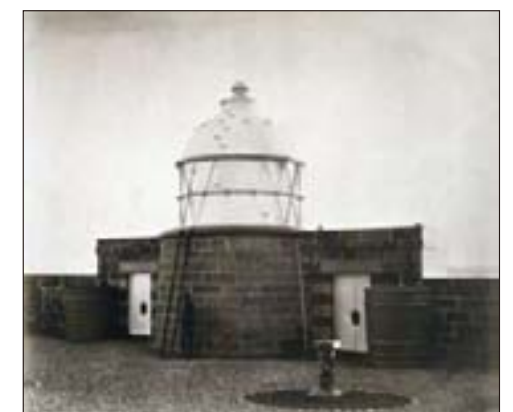
檜野埼燈台 明治3(1870)年7月8日に点灯 設計はR.H.ブランドン『鹿鳴館旧蔵写真帖』より
