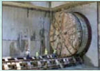
アジア側の巨大なシールドマシン(TBM)がウシュクダル駅に到達 2009年7月
