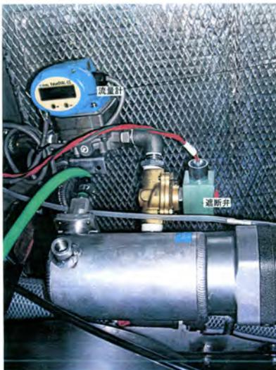
図 7-14 冷却水制御装置 その1
