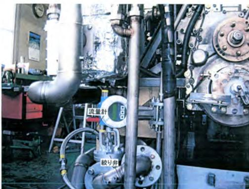
図 7-16 水蒸気量制御分配装置
