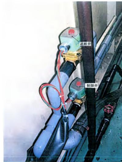
図 7-15 冷却水制御装置 その2
