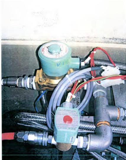
図 7-12 副燃焼室の燃料制御弁
