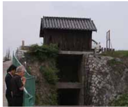
一ノ口水門（水門上部右は水門の案内）
