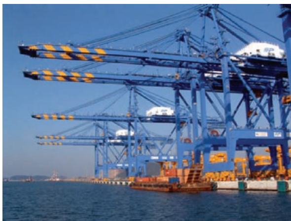
図2-32 釜山新港に装備された世界最大の岸壁クレーン
