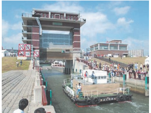
図2-15 荒川ロックゲート
