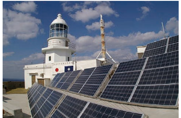
図2-20 自動化された女島灯台 (出典：長崎海上保安部)
