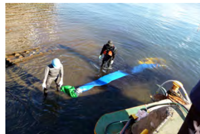
外板用 IWC 装置の設置
