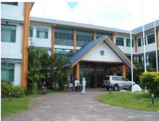
ツバル政府庁舎（台湾の支援*により建設）
