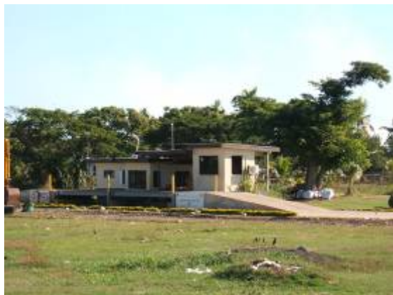
入口に設置されたトラックスケール (ラウトカ市廃棄物処分場)
