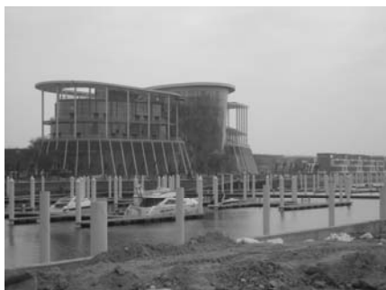
図 建設が進むヨットハーバー
