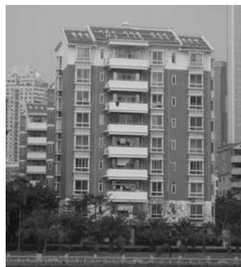
図 太陽光パネルが設置された建物
