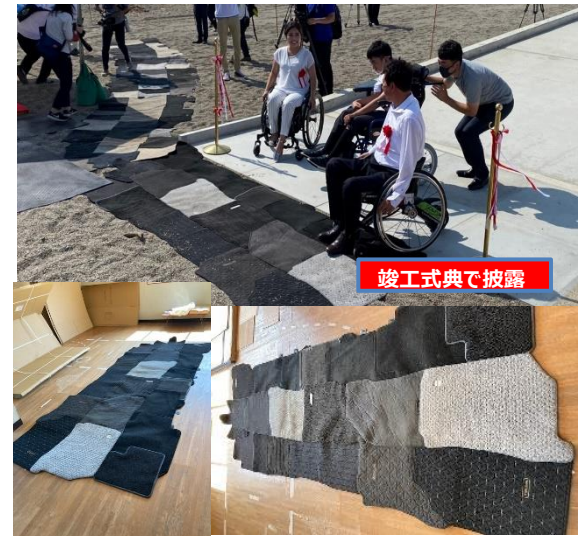
自動車の廃材のフロアマットを活用した砂浜での車イス用車道の製作
