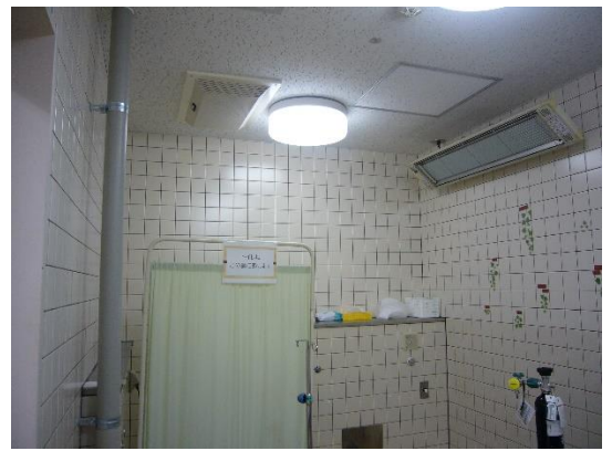
診察室 (除染室) の HEPA フィルター取付 工事 2
