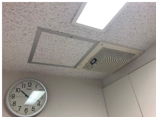
診察室 (除染室) の HEPA フィルター取付 工事 1
