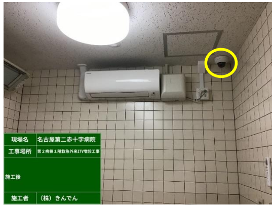
カメラモニター取付工事 (除染室)
