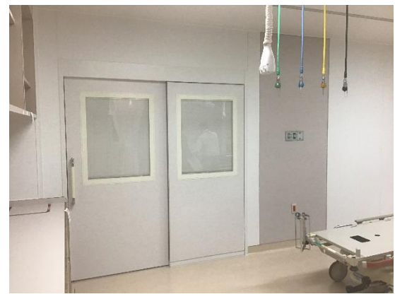
救急治療エリア個室化工事（完成 4）
