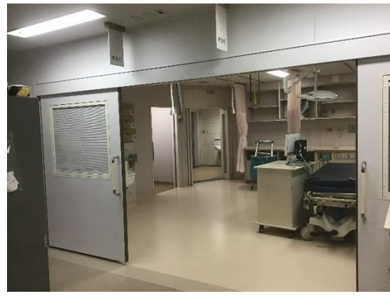
救急治療エリア個室化工事（完成 3）
