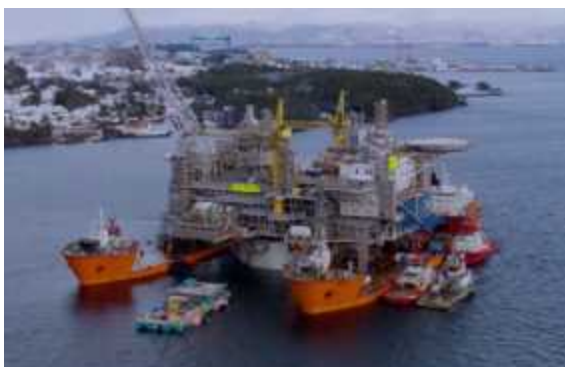
図 2.4 : Aasta Hansteen SPAR のフロートオーバー方式による上載設備の設置 (出典 : https://www.youtube.com/watch?v=OdHZM3FQXmI )
