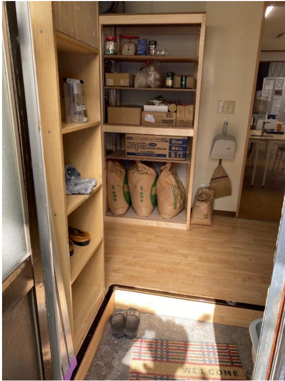
⑤ バックヤードの改修
