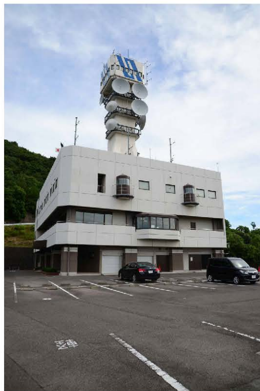
海上保安庁備讃瀬戸海上交通センター 外観写真
