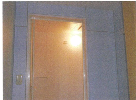
シャワー室設置後
