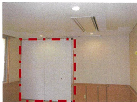
スライディングウォール設置後
