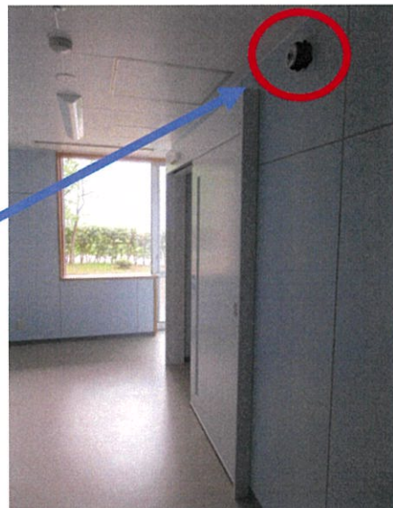
マノメーター取付 (場所：防護服脱着室)
