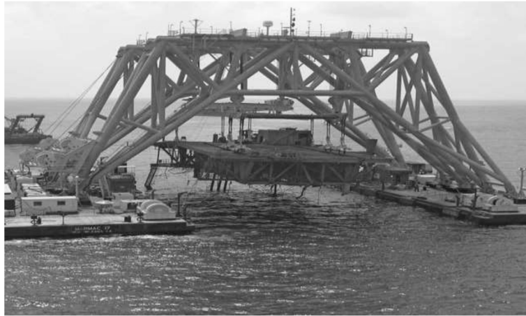
図 5-17 Bottom Feeder 吊り上げシステム (Versabar Bottom Feeder Lift Systems)
