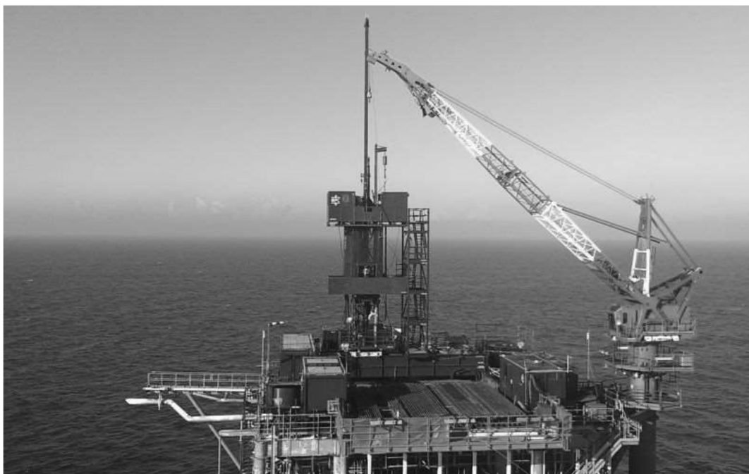
図 5-4 撤去時における坑井介入技術（油圧改修）
