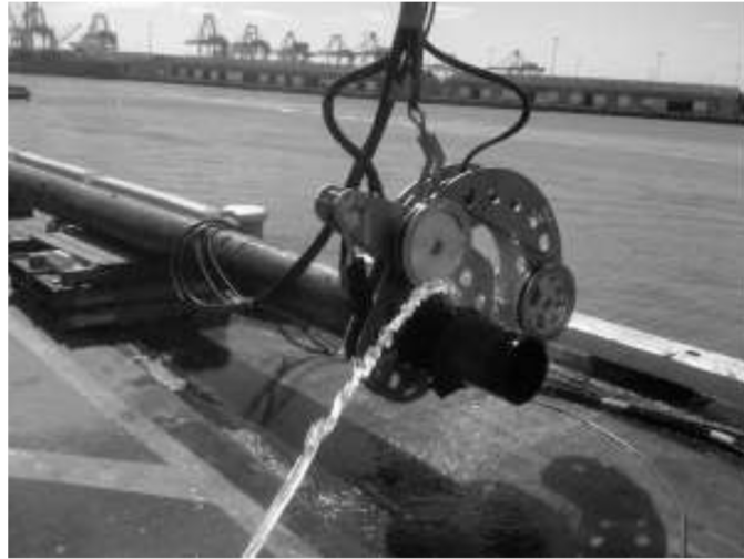
図 5-9 ダイヤモンドワイヤー切断システム（ダイバーによる切断）
