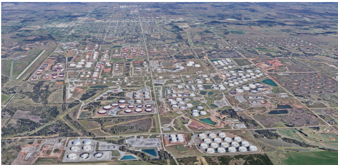
図-2 クッシングの貯蔵タンク
