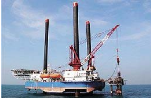
(9)オフショア建設船・ジャッキアップ (Teras Conquest) (Teras Offshore website)
