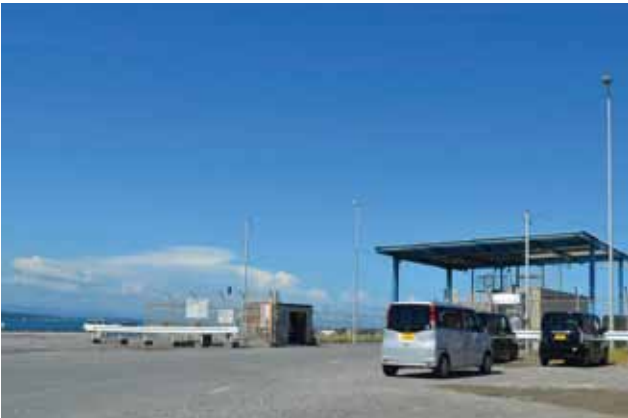
■ 御前崎港西埠頭位置
