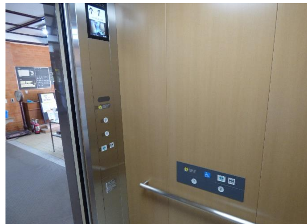
エレベーター改修後③
