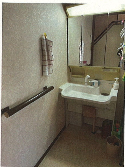
車椅子使用洗面台、風呂場ドア
