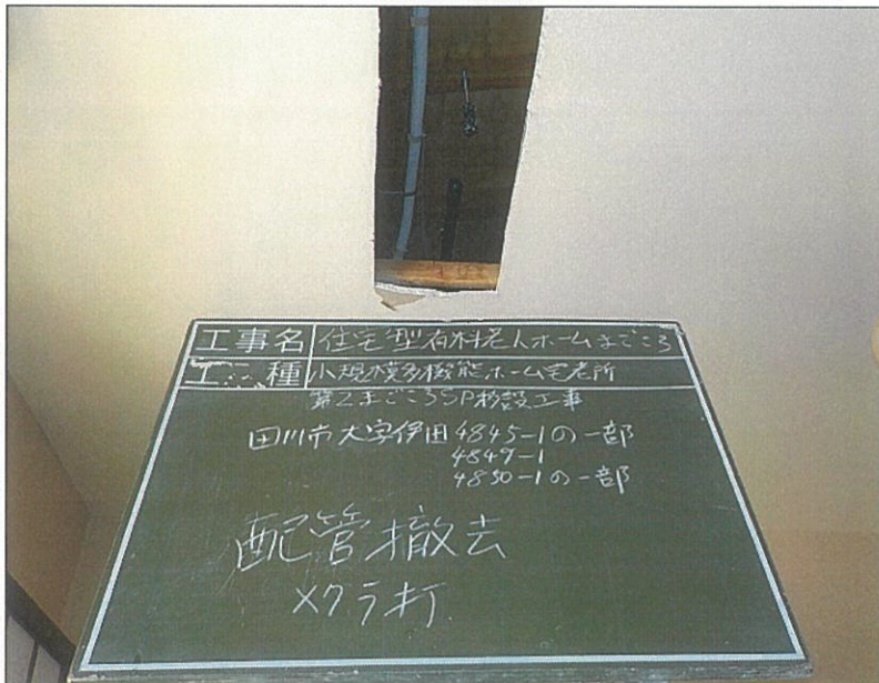
SPヘッド仮撤去②
