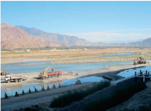
▲バルカシコート堰建設 (2021年11月23日)
