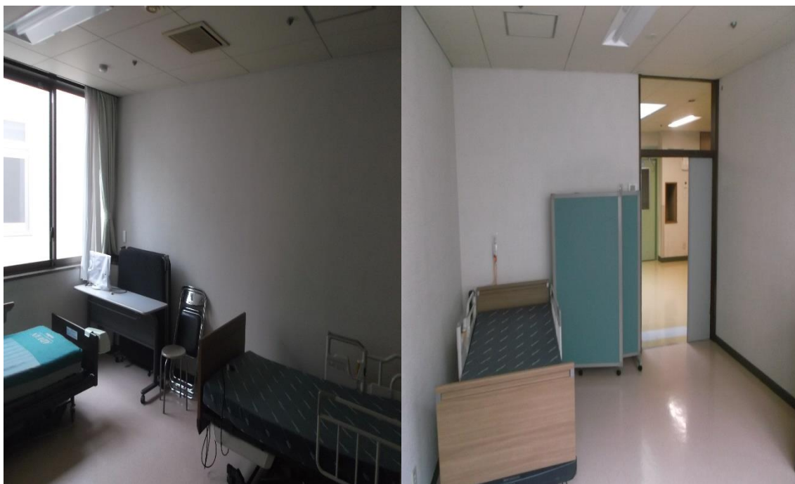
静養室 改修前
