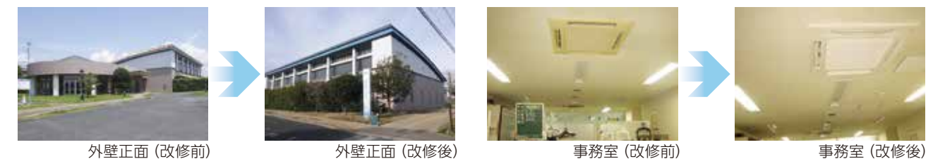
外壁正面 (改修前)
