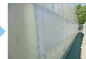
上屋シート (改修後)
