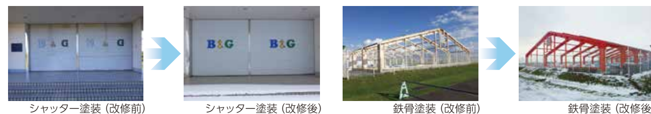
シャッター塗装 (改修前)
