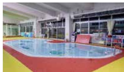
幼児用プール (改修前)
