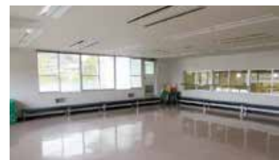
多目的ホール (改修前)
