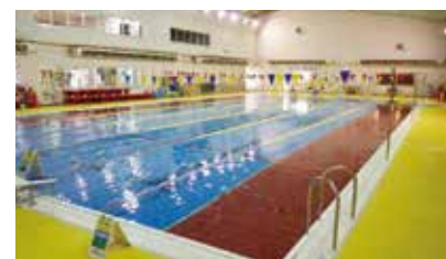
25Mプール (改修前)
