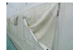
上屋シート (改修前)
