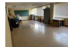
ミーティングルーム (改修前)
