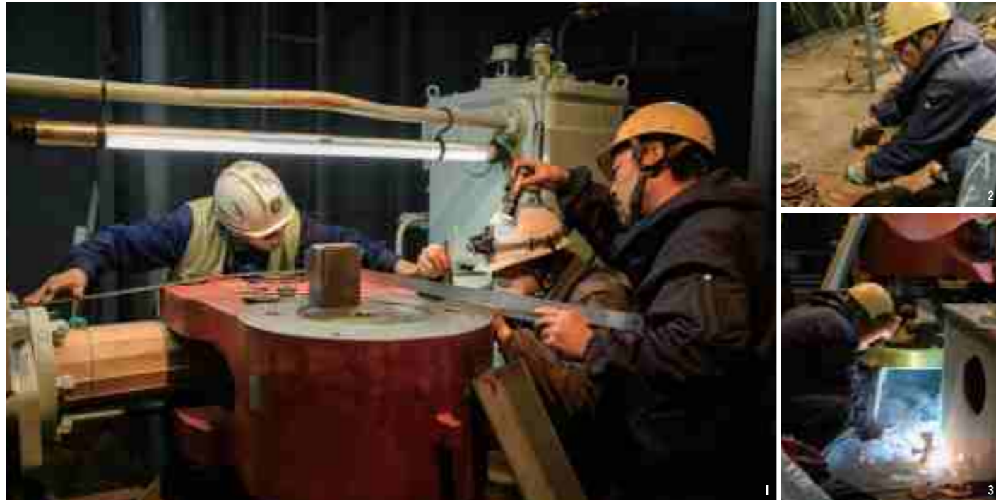
舵取機をはじめ、船の動力を生み出すような核となる機械の取付だからこそ、わずかな誤差が命取りになりかねない。熟練技をもつ作業員が声をかけ合い、一つひとつの作業を慎重に進めていく
