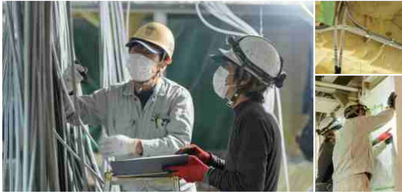
船内の四方八方に張り巡らされている無数の電線。もちろん、不要な電線は1本たりともない。図面に間違いがないかどうか、現場の作業員らはコミュニケーションを取りながら確認作業を行う
