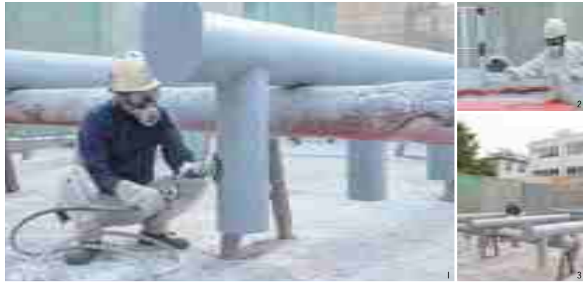
1.凹凸をなくし、滑らかなカーブをつくるには熟練の技が必要 2.スプレーを噴射し、全体をムラなくきれいに仕上げる 3.塗装を終えたパーツは、次々と船に取り付けられていく
