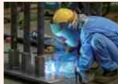
溶接をはじめ、幅広い技術習得が可能
