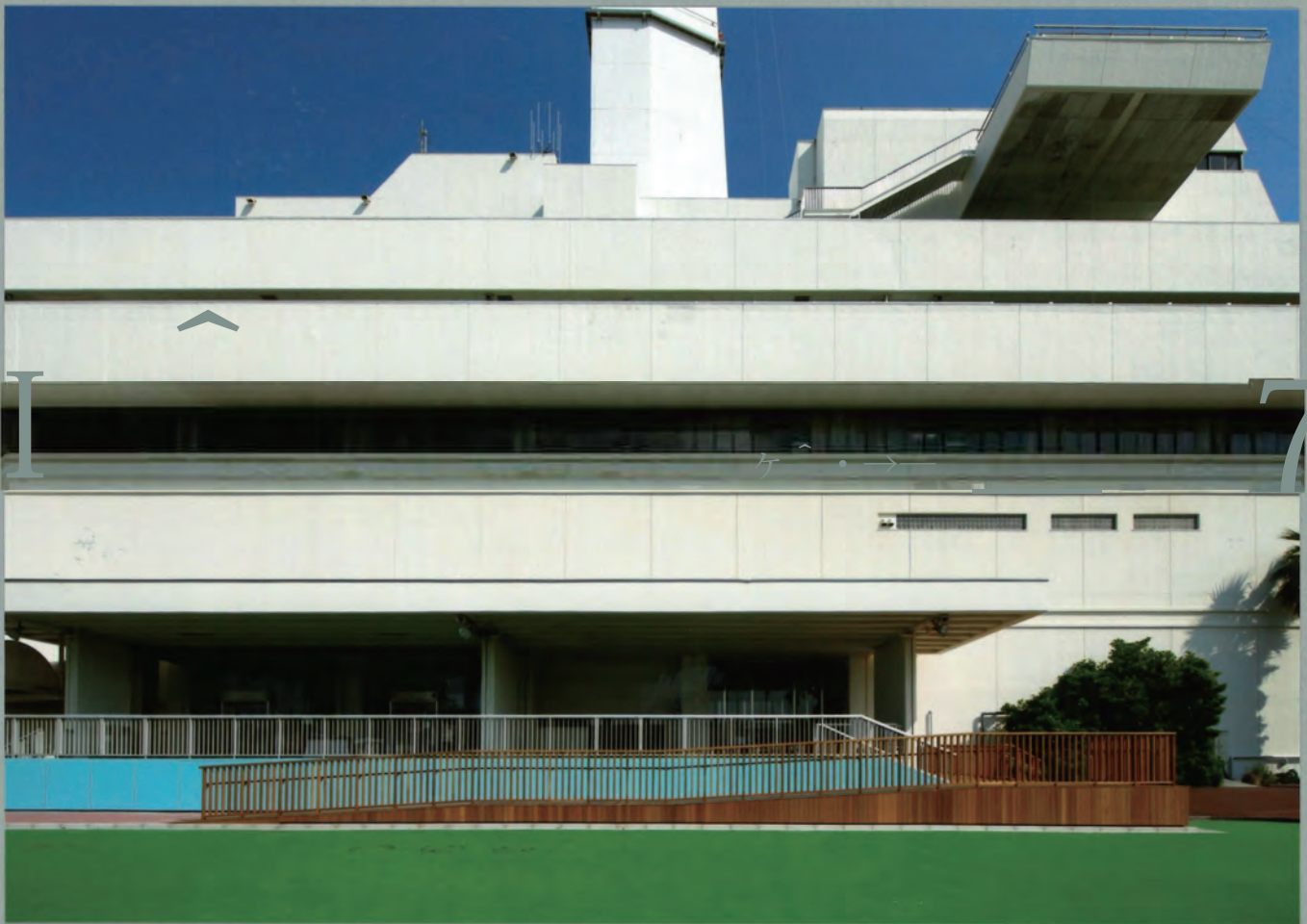
屋外スロープ
