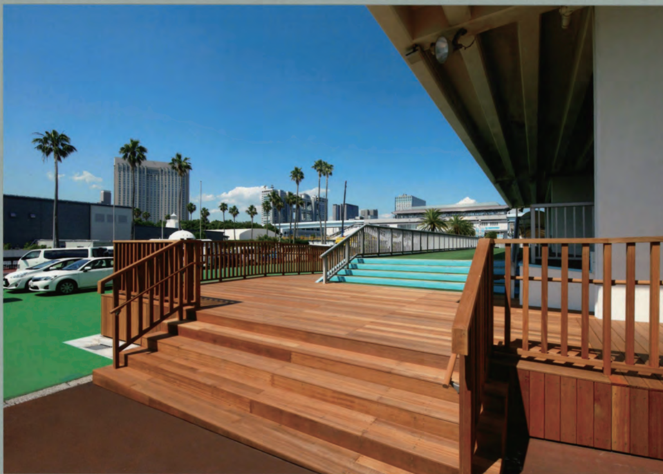
屋外スロープ
