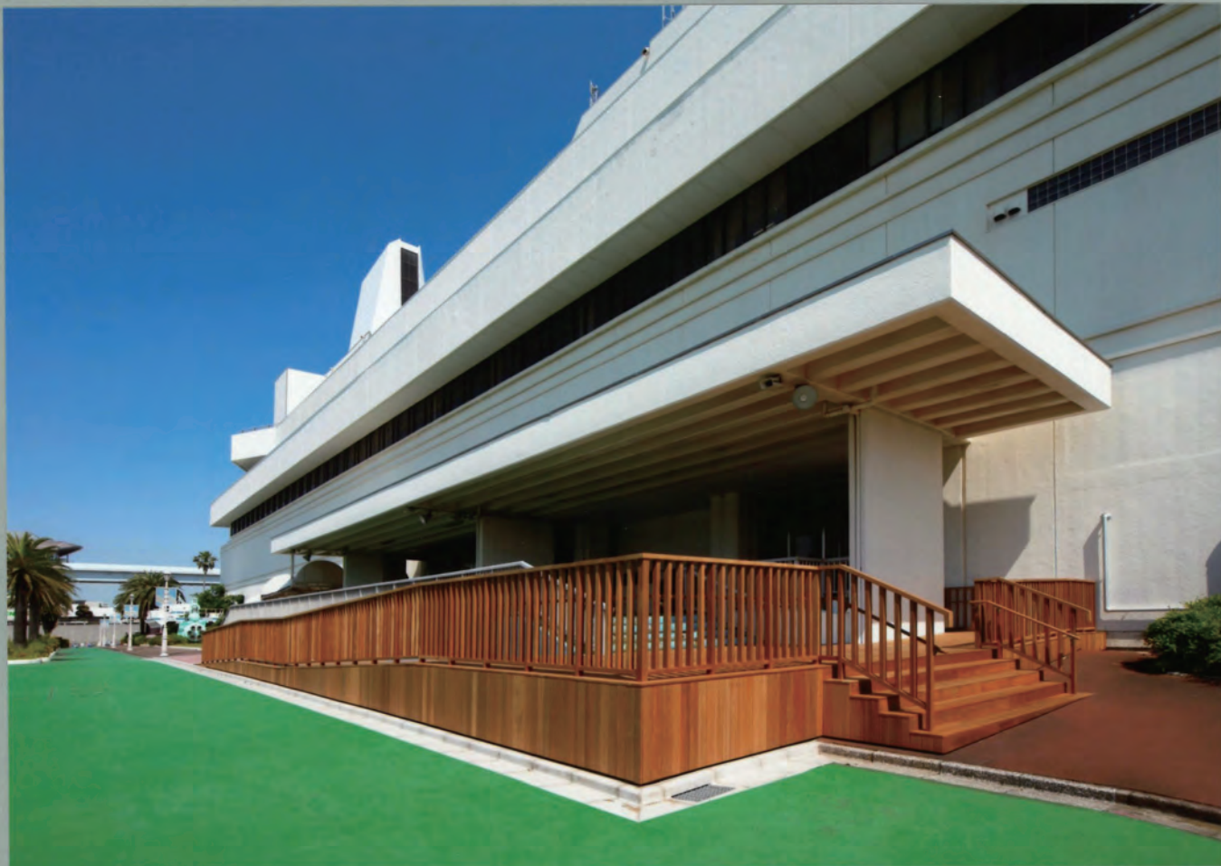
屋外スロープ
