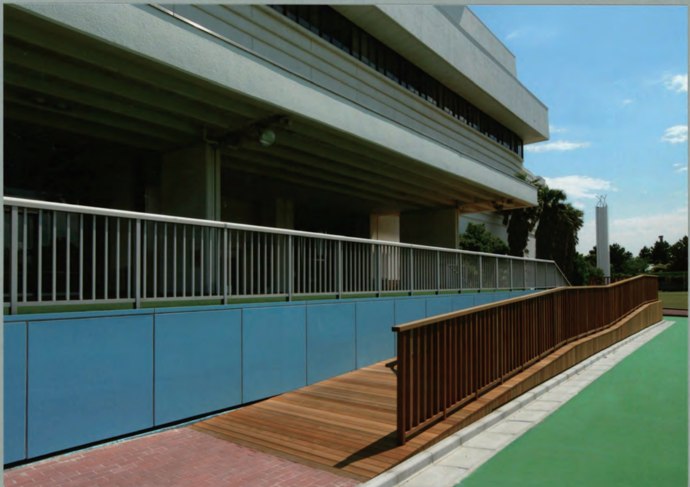
I屋外スロープ
