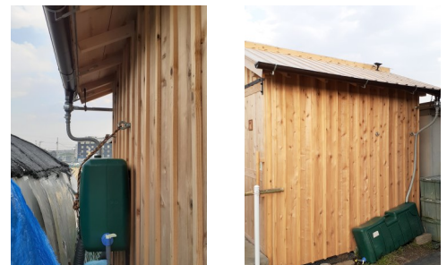
屋根には太陽光発電用機材
