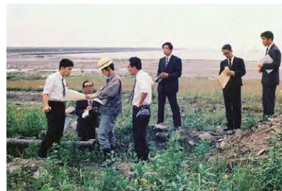
建設用地として購入した13号地の調査を行う関係者
