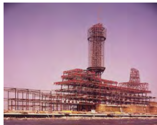
船の科学館の鉄骨構造
