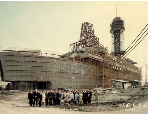
外壁ができ形が整いはじめた船の科学館
