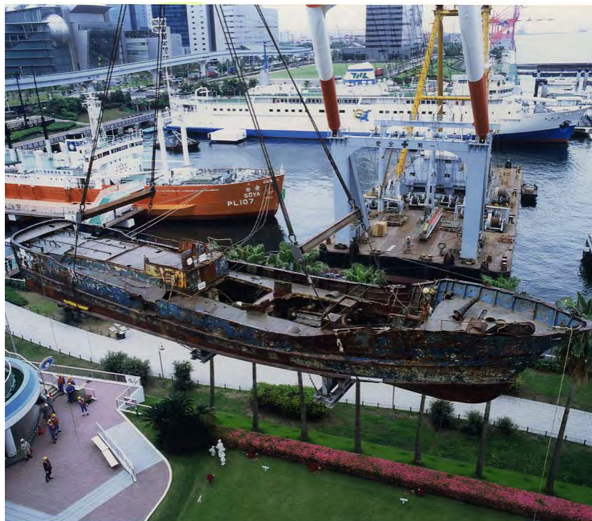
北朝鮮工作船の搬入設置作業
