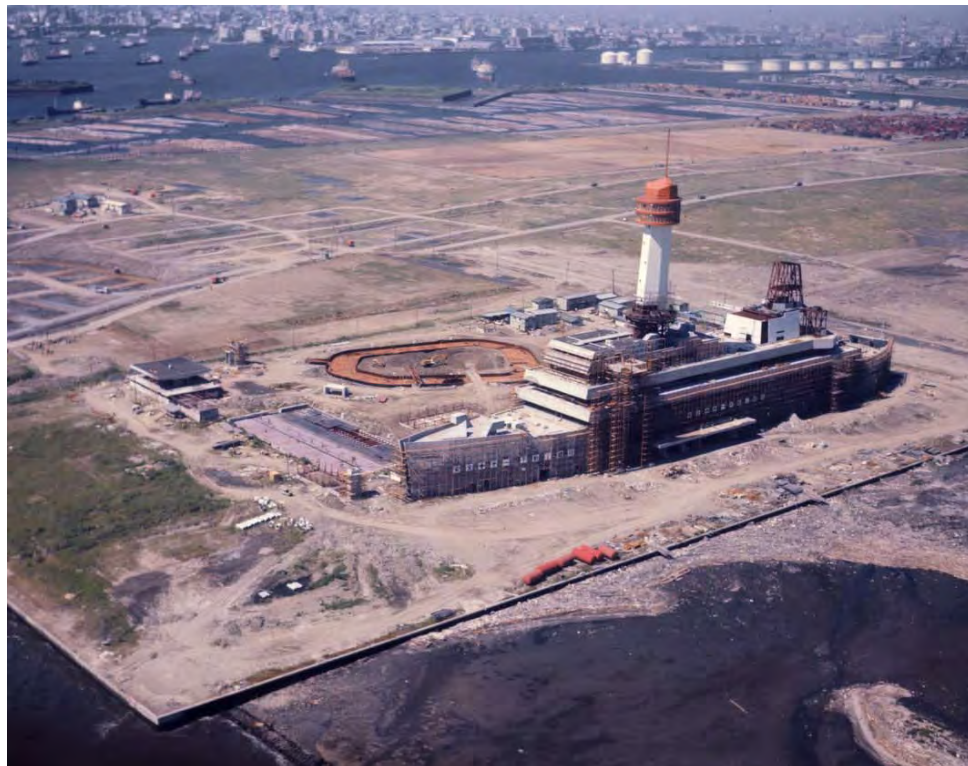
建設が進む船の科学館の空撮(プール工事に着手)
