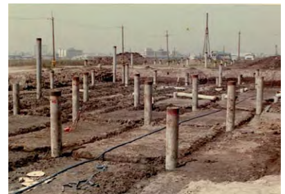
杭が打設された建設用地
