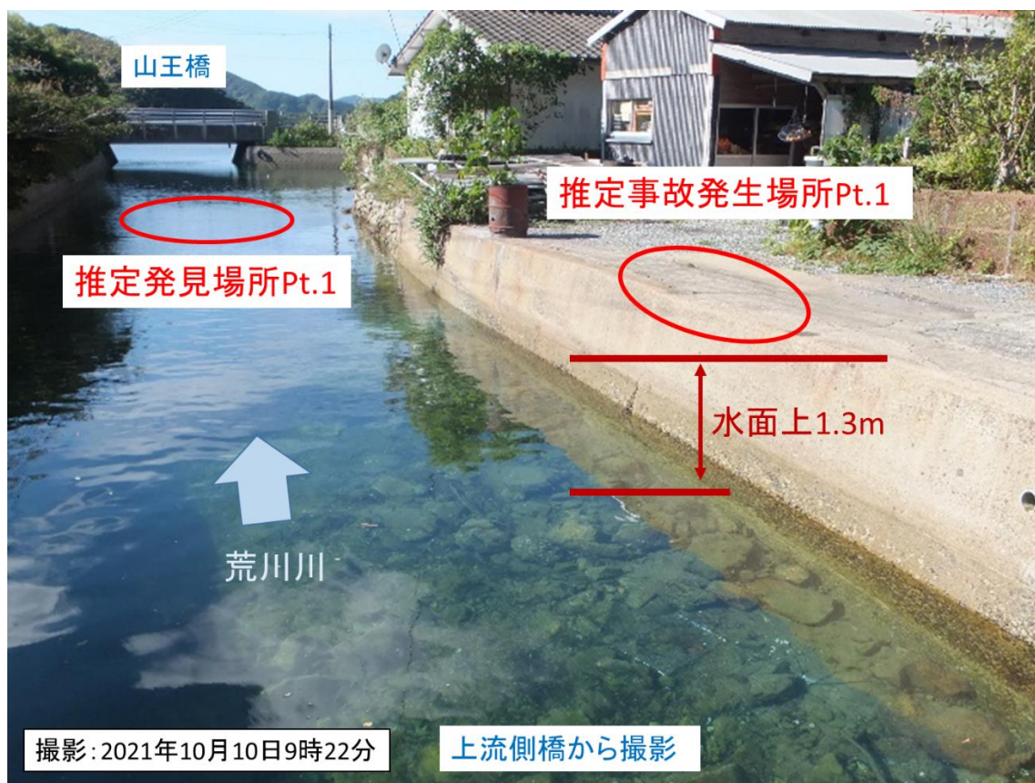
図-6.5 事故現場と予想される場所の状況 (Pt.1、荒川側右岸側、2021年10月10日9時)
