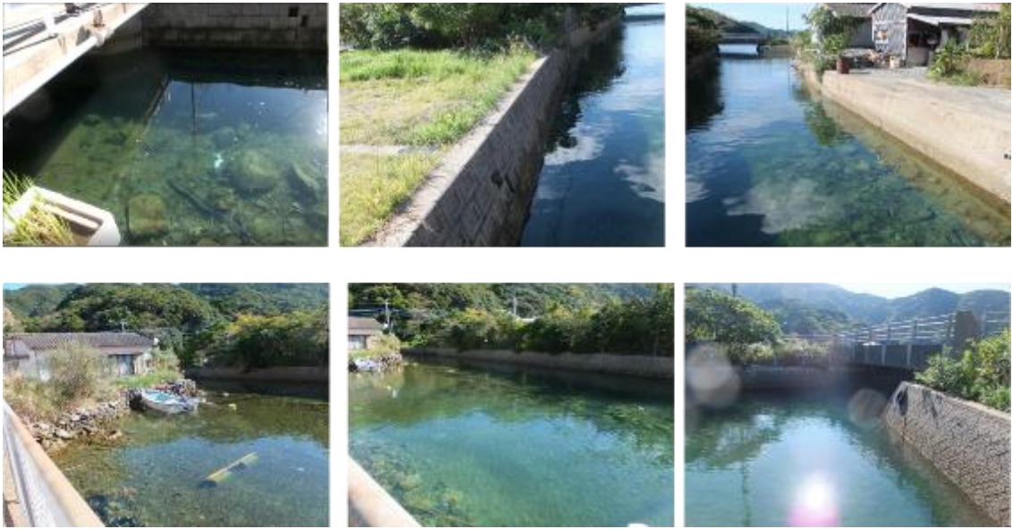
図-5.12 調査時の事故発生場所付近の潮位状況（2021年10月10日9時すぎ、事故発生時とほぼ同じ潮位）
