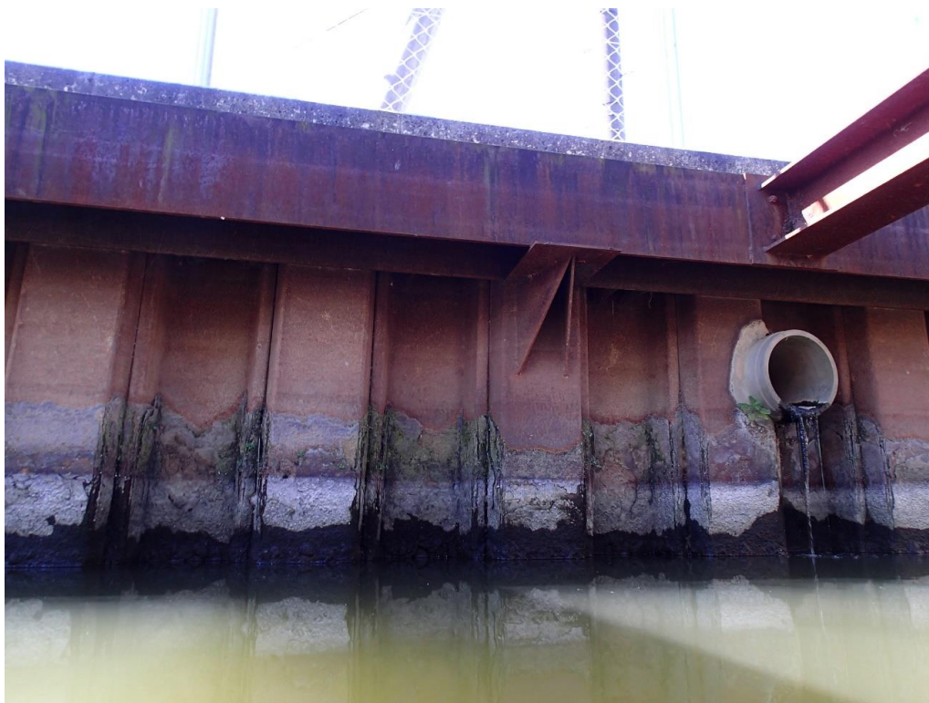
写真-7.6 落水場所上流側から左岸方向（2021年10月9日）
