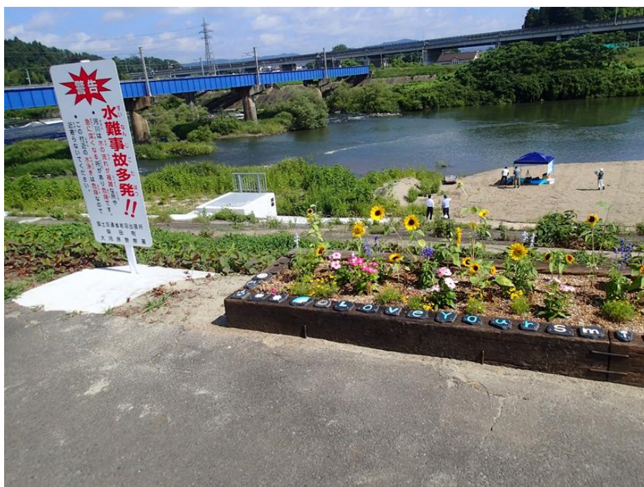
図-3.6 白石川河川堤防上から調査場所方向(上流方向、JR東北本線白石川橋)
