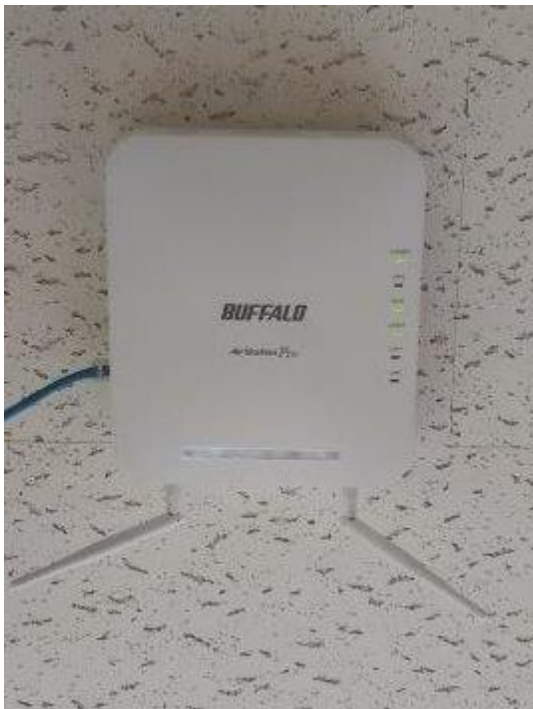
NS コール設備更新工事 (Wi-Fi 設置_システム連動用)
