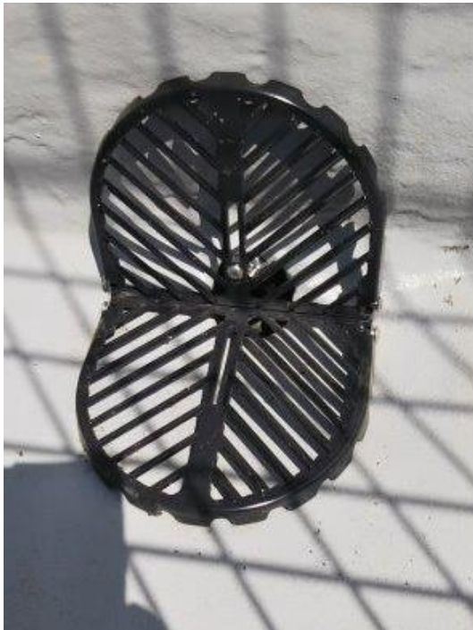
屋上防水工事 (各所_ドレン廻り)
