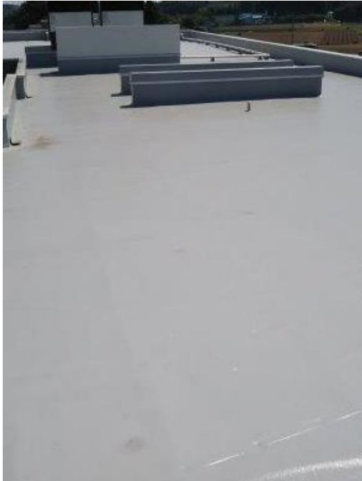
屋上防水改修工事 (第2工区_外断熱部)
