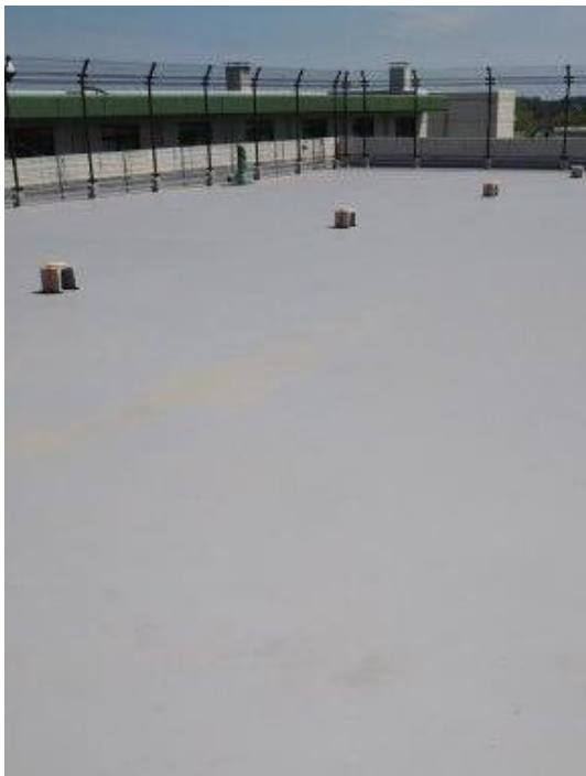
屋上防水改修工事 (第1工区_屋上庭園部)
