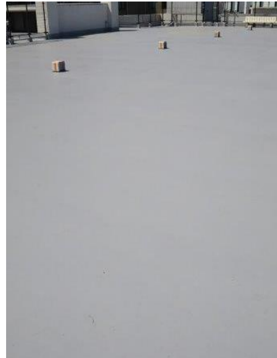
屋上防水改修工事 (第1工区_屋上庭園部)
