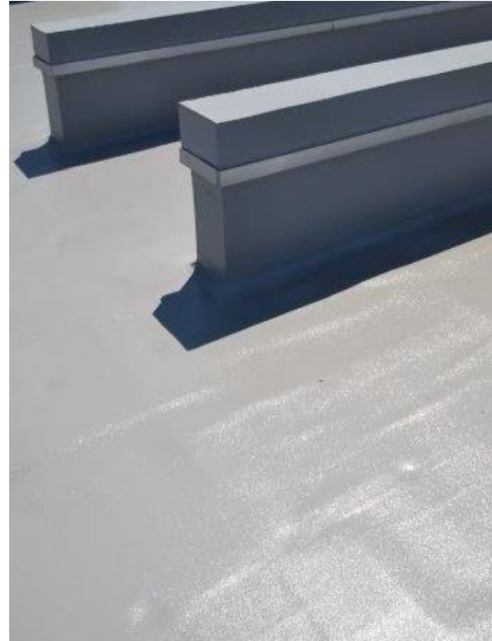
屋上防水改修工事 (第2工区_外断熱部)
