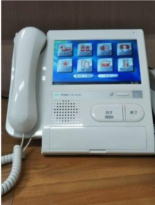
NSコール設備更新工事 (各階_親機)
