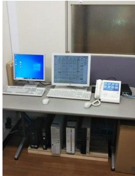
NSコール設備更新工事 (介護ソフト連動 PC 類)
