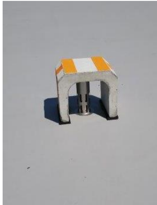
屋上防水工事 (屋上庭園_脱気管廻り転倒防止処置)
