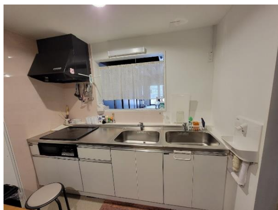
改修後(2層シンクと手洗い設置)
