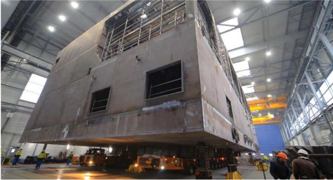
(写真) Chantiers De L'Atlantique で建造中の洋上変電設備
