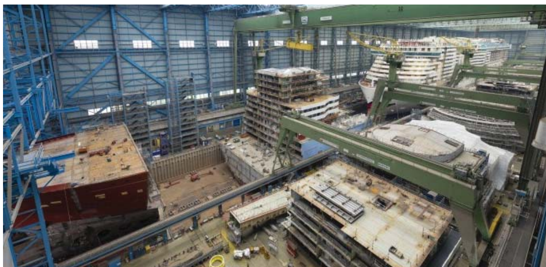
屋内建造ドック（出典：Meyer Werft）
