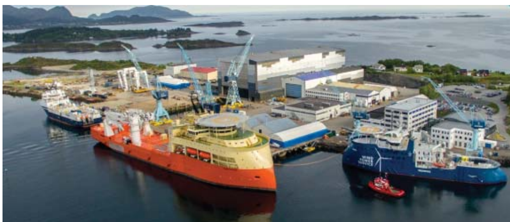
Ulstein Verft 造船所全景（出典：Ulstein Verft）
