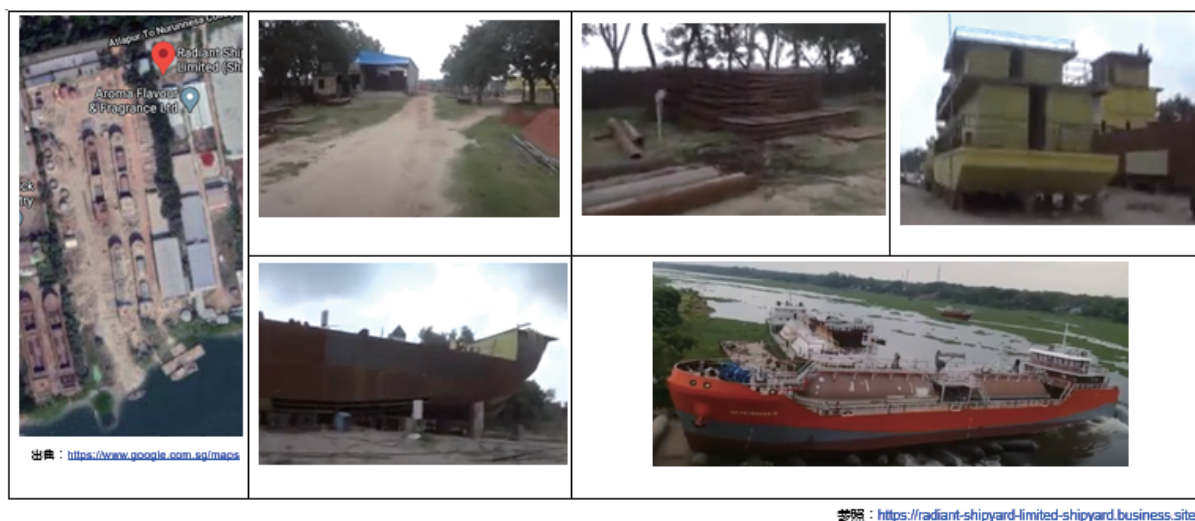
図 5-5 : Radiant Shipyard Limitedのヤード
