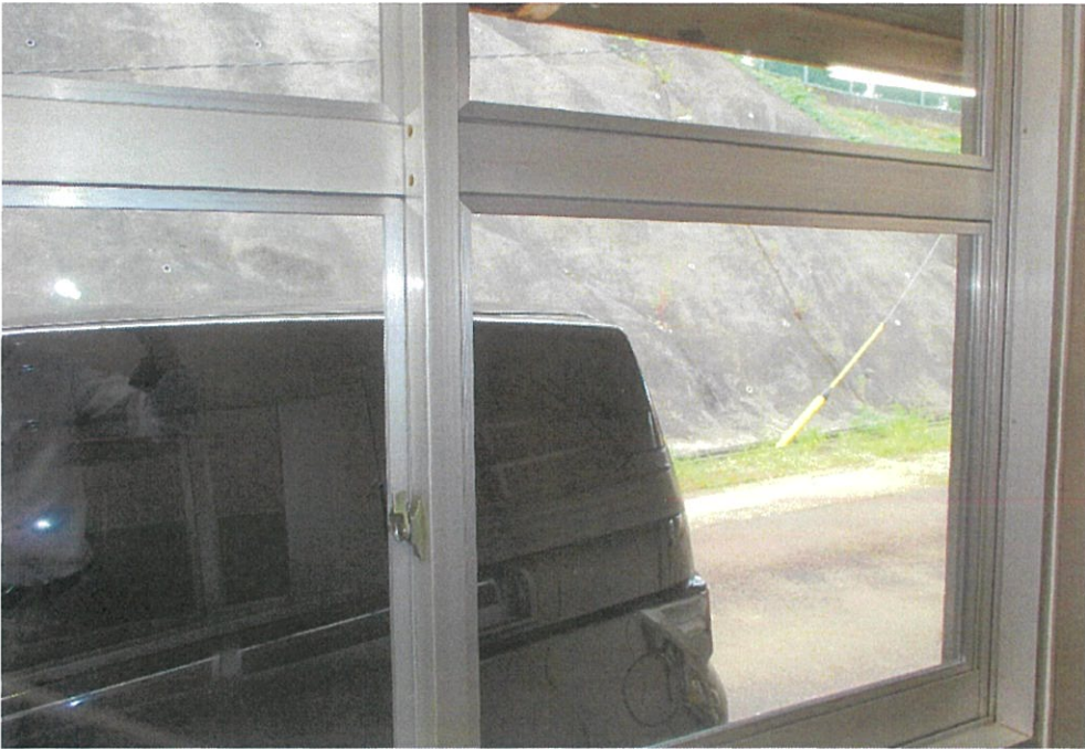
作業棟改修工事(二重ガラス窓改修)
