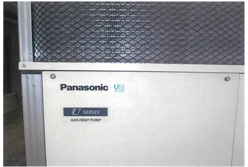
エアコン設置工事(室外機)
