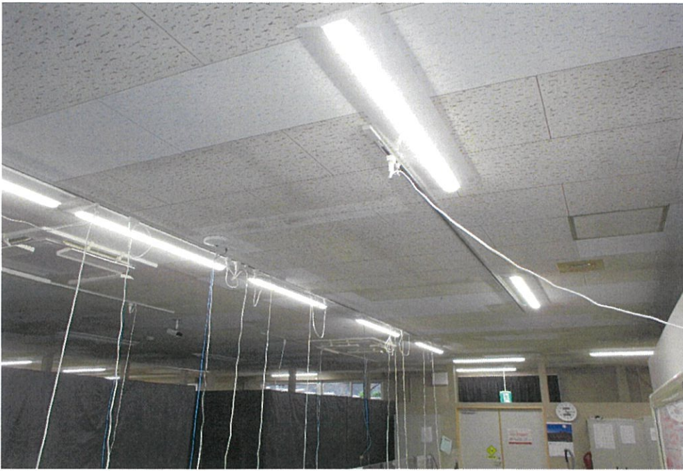
作業棟改修工事(照明・電気配線)
