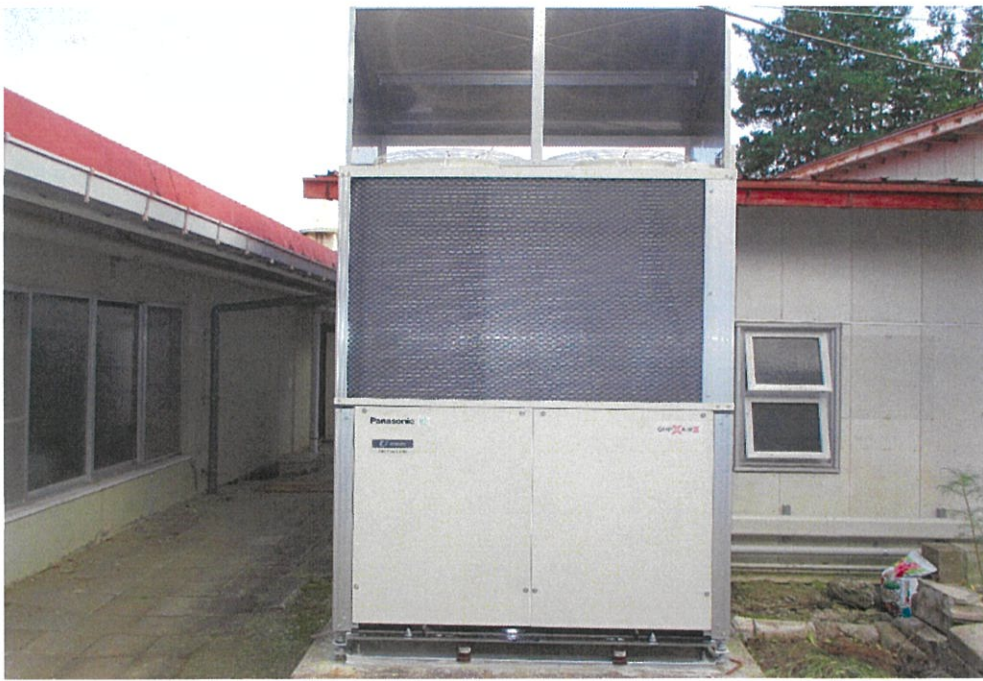
エアコン設置工事(室外機)
