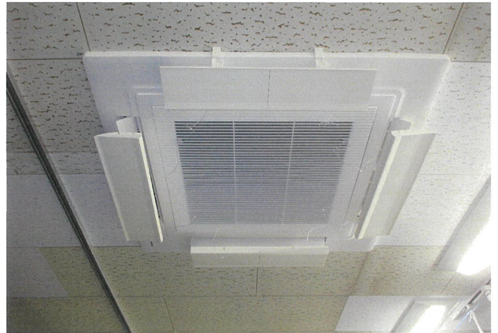
エアコン設置工事(室内機)
